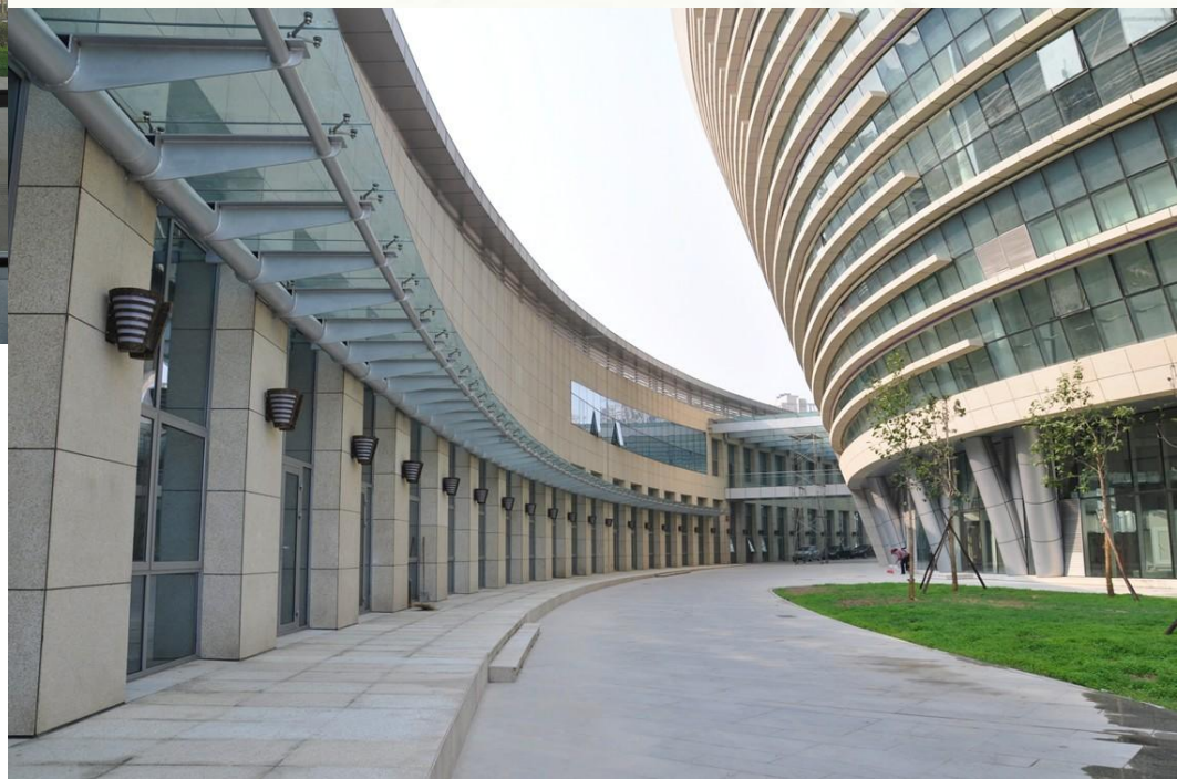
新馆屋顶、外围围护等使用真空玻璃 实景二
