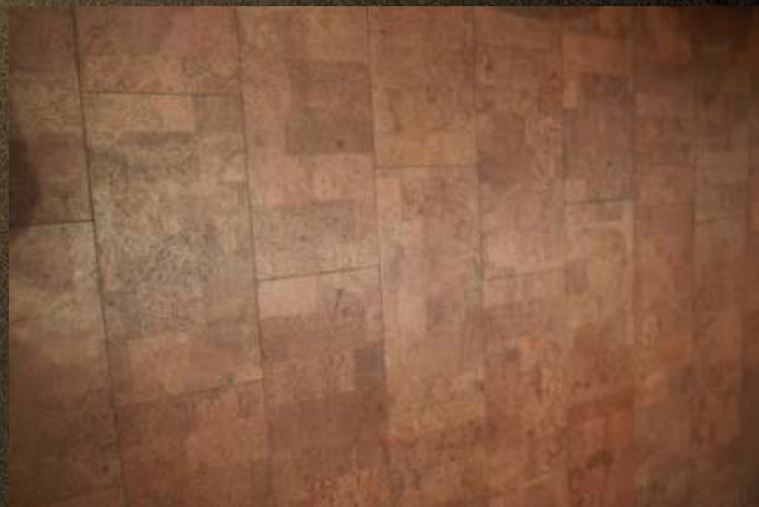
西一楼软木地板
